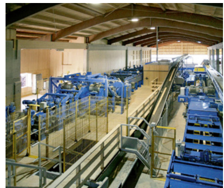
Zerspannerhalle: Hier sollen bis Jahresende Sprinkler installiert werden
