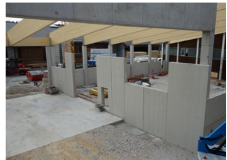
Bereit für die Zukunft: Sprinklerbecken und Erweiterung der Hobelhalle (v. li.)
